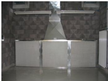
IPE-Zuluftwand für Trockenraum zur gleichmäßigen horizontalen Trocknungsluftverteilung.
