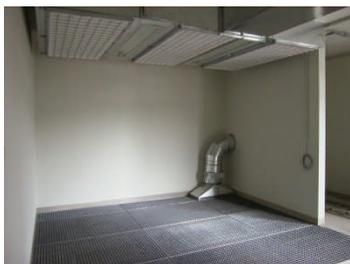
Unterflurabsaugung mit integrierten Absaugboxen TUF mit Doppelfiltrations system. Zuluftdecke mit integrierten Leuchten
