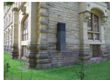
Zuluft-Ansaugturm für Lackieranlage in Edelstahl ausführung mit angepasster Farbgebung.
