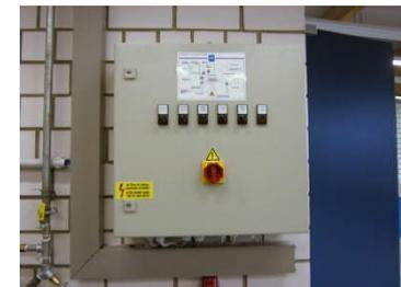
Schaltschrank mit SPS-Steuerung, Sommer-/Winterbetrieb, diverse Leistungsstufen, Be- und Entlüftungsbetrieb, Trocknungsbetrieb, Pneumatische Ansteuerung der Stell- und Regelorgane im Ex-Bereich, Programmwahlschalter einschließlich Signal- und Betriebsbereitleuchten.
