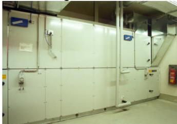
Durch die spezielle Einstellung der Systeme wird im Spritzraum immer ein leichter Überdruck aufrecht erhalten um Staubeintritt beim Öffnen von Türen, usw.
