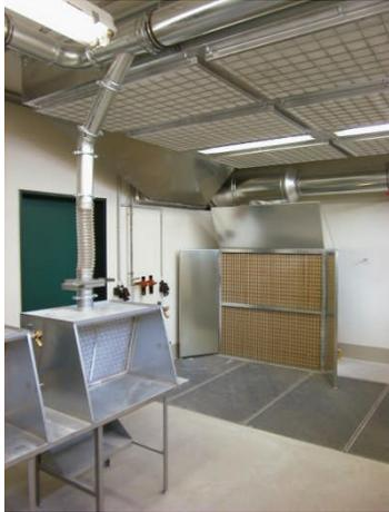
Lackierraum mit kombinierter Wand-/Unterflurabsaugung, Zuluftanlage mit integrierten exgeschützten Leuchten in der Zuluftdecke.
