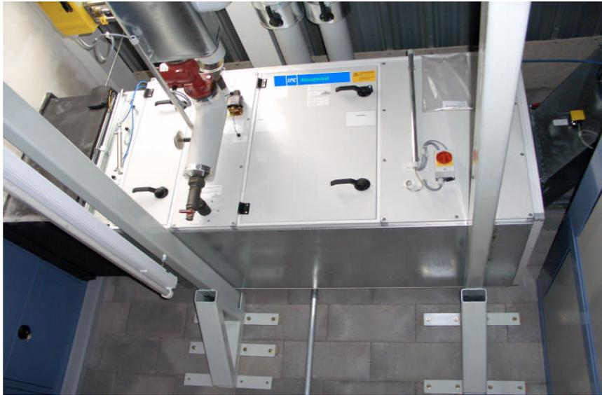
Zuluftgeräte ZLG 1-stufig/2-stufig in Kastenbauweise, bestehend aus: Ansaugvorfilter, Frostschutzjalousie mit pneum. Stellantrieb einschl. Magnetventil, Heizregister, 1x Zuluftventilator mit einstufigem wahlweise zweistufigem (polumschaltbaren) Motor, doppelwandig isolierte Ausführung. Wetterschutzdach als Option.
