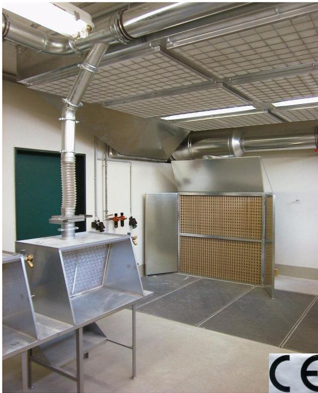
Trockenspritzwand (TSW) aus verzinktem Stahlblech mit Labyrinthfilter als Vorfilter und Glasfasermatten als Nachfiltereinheit.
