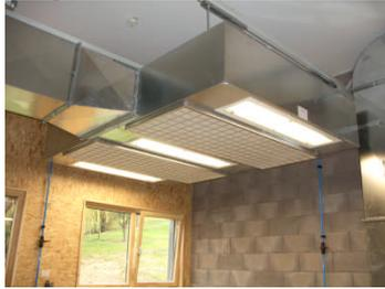
Unterflurabsaugsystem TUF mit beleuchteter Zuluftdecke
