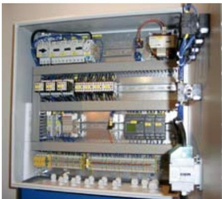
Die SPS-Steuerung gewährleistet ein bedienfreundliches, vollautomatisches Arbeiten:
